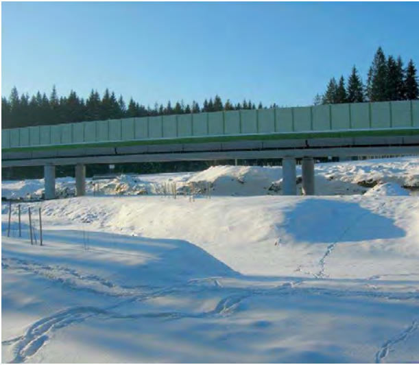
Малюнок 72. Перехід для диких тварин під 200-метровим водоводом на швидкісній автомагістралі S69 в районі с. Звардонь, Південна Польща. Помітні сліди тварин на снігу (Jędrzejewski et al., 2009).
