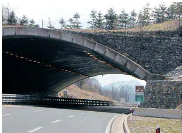
Малюнок 71. Великий наземний перехід (зелений міст) завширшки 120 м на шосе А6 у Хорватії (Jędrzejewski et al., 2009).
