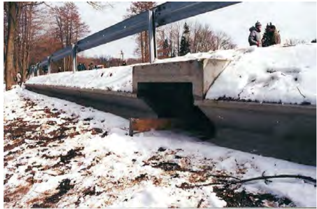
Малюнок 70. Перехід для земноводних на дорозі регіонального значення біля м. Кудова-Здруй, Південно-Західна Польща (Jędrzejewski et al. 2009).
