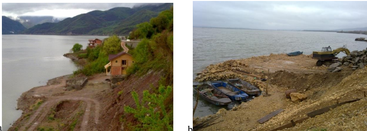
Fig. 25 Uređivanje individualnog stambenog prostora na području opština Svinjica i Coronini, koje su izmeštene na području izgrađeno zaravnavanjem i ojačanjem dunavske obale
